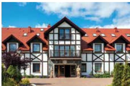
Restauracja Nordowi Mól, Celbów, zintegrowany system instalacji OZE (pompa ciepła, instalacja PV i solarna).
